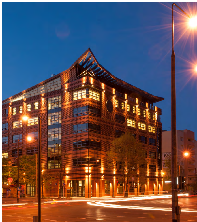
Budynek C Szkoły Głównej Handlowej w Warszawie
